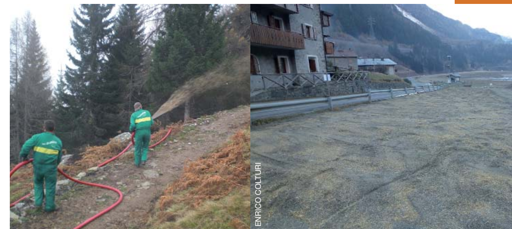
Inerbimento dimostrativo con idrosemina in Valgerola e, a destra, con fiorume in sito soggetto a spostamento terra in Val Pola.
